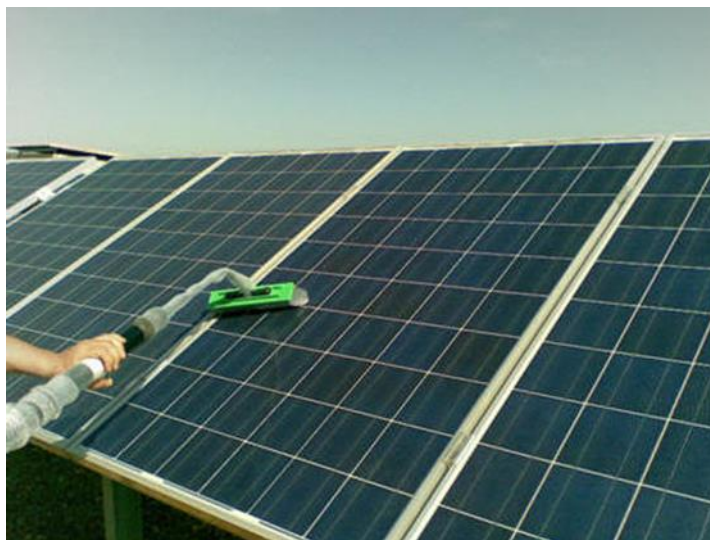
Figura 1-36 Limpieza de Paneles
