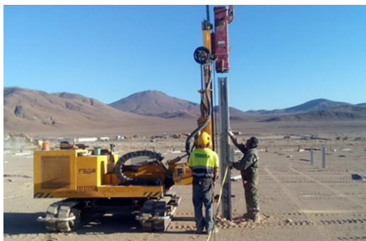
Fotografía 1-19 Representación de hincamiento de estructuras metálicas
