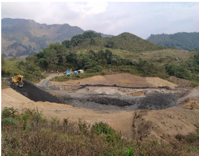
Construcción de la Zodme - proyecto de gestión de sedimentos, embalse Tunjita Fuente: AES Colombia, agosto de 2022.
