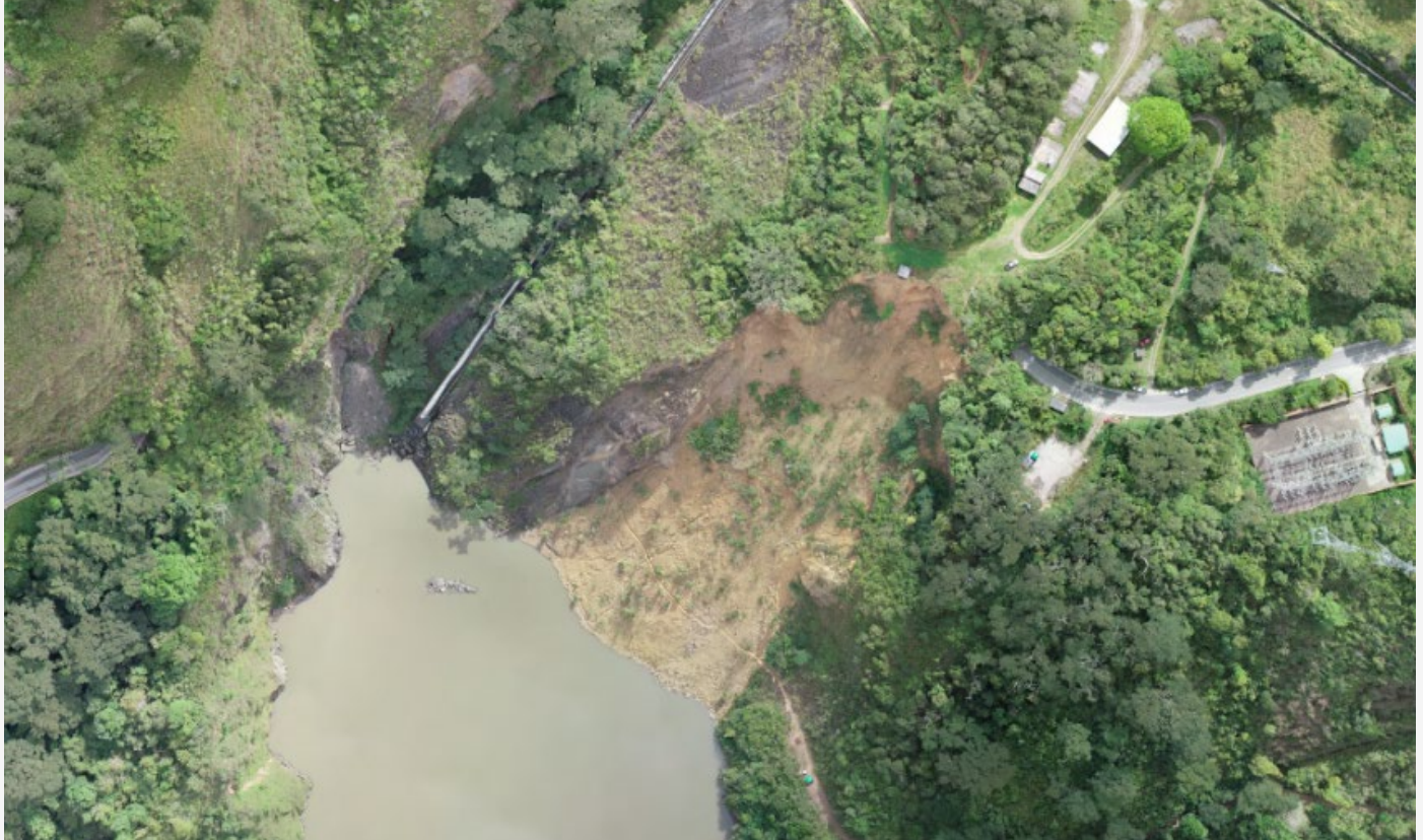
Panorámica del talud Tunjita, sitio 20 Fuente: AES Colombia, vuelo con dron - noviembre de 2022
