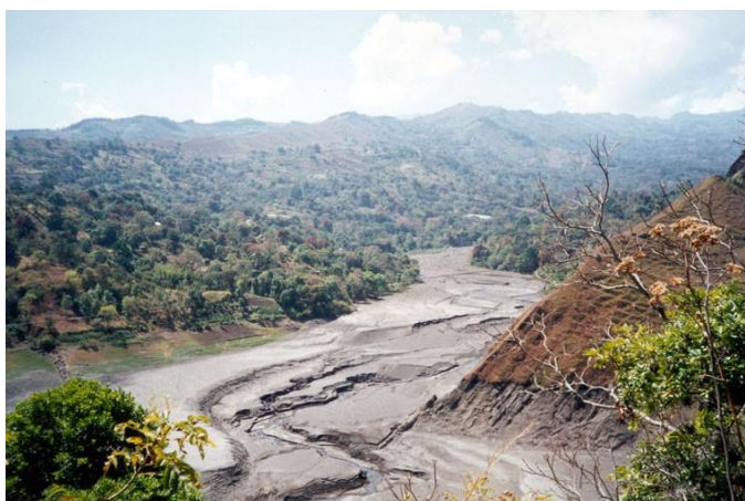
Foto 2.12 Banco de sedimentos en el embalse útil, parte alta del embalse. Visible en periodos de estiaje
