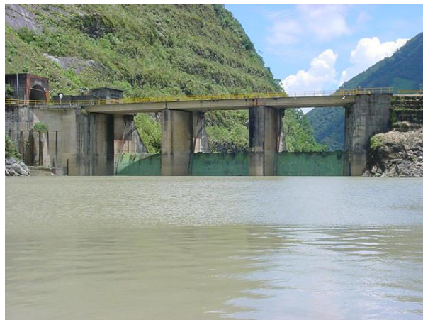
Foto 2.2 Compuertas del rebosadero
