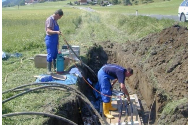
Figura 3-13 Instalación de cables de media tensión y fase subterráneos
