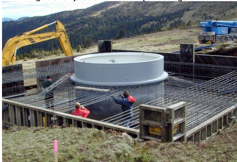
Figura 3-10 Ejecución fundación tipo de aerogenerador
