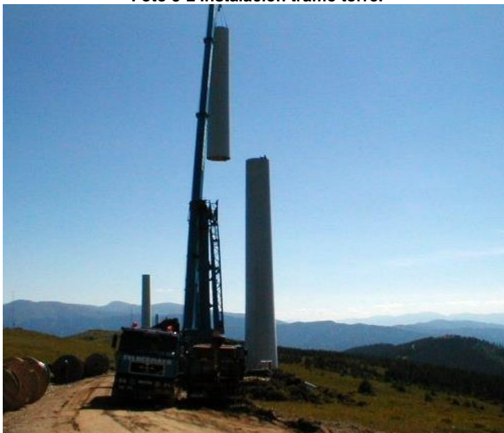
Foto 3-2 Instalación tramo torre.
