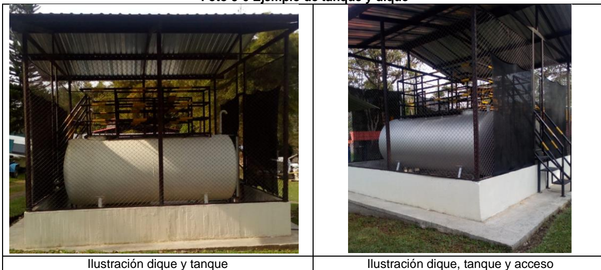
Foto 3-6 Ejemplo de tanque y dique
