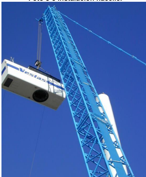
Foto 3-3 Instalación nacelle.
