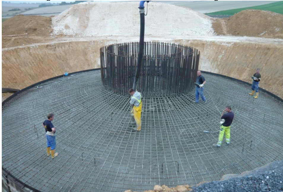
Figura 3-5 Construcción de la fundación de un aerogenerador
