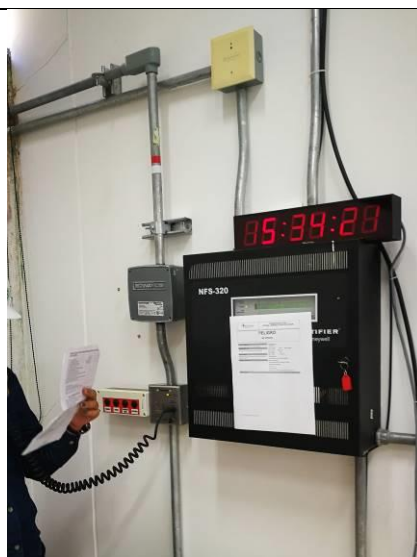
Foto 17. Realización de pruebas del sistema de alarma y perifoneo
