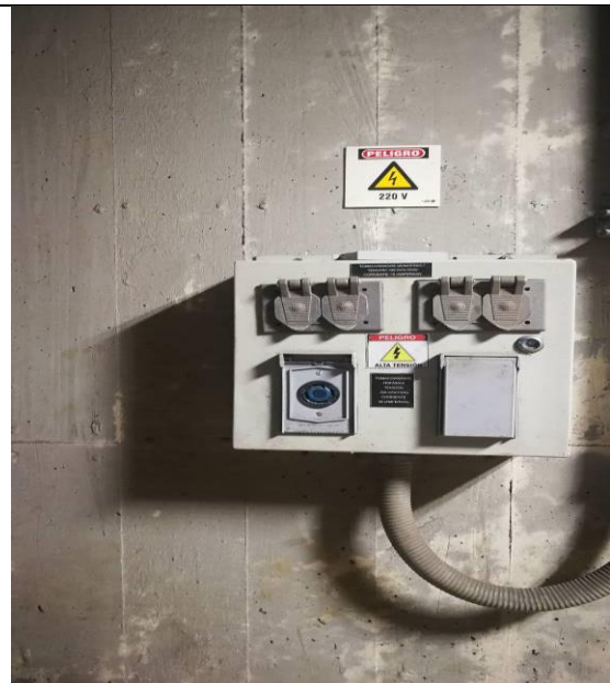
Foto 21. Tomacorriente trifásico sin protector Unidad 6
