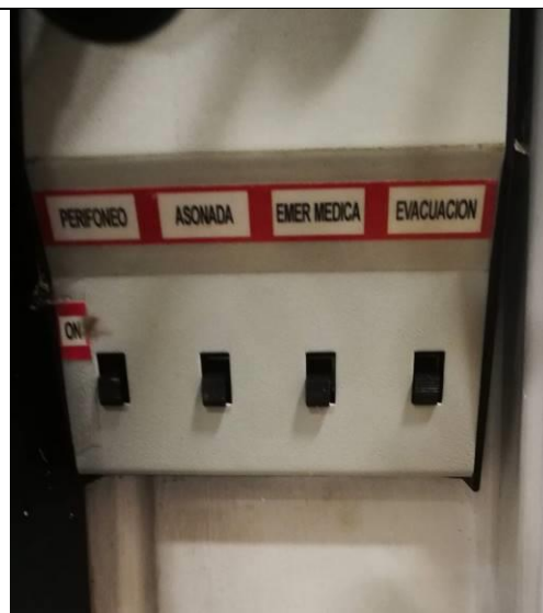
Foto 5. Interruptores de tono del sistema de perifoneo
