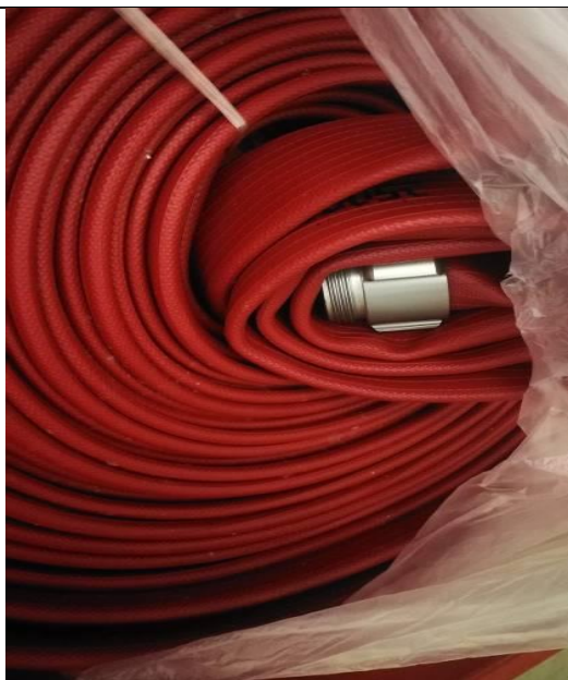
Foto 16. Manguera Gabinete No. 17 sin boquilla
