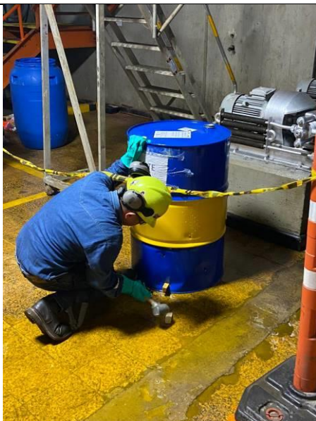
Foto 20. Instalación de cuña para control de fuga
