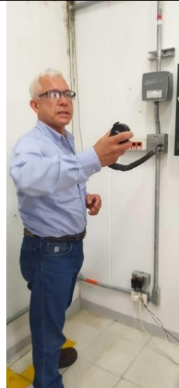
Foto 23. Realización de pruebas del sistema de alarma y perifoneo
