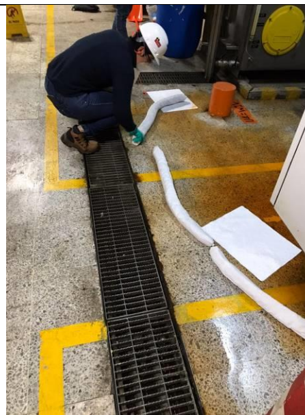
Foto 15. Aspectos Simulacro Casa de Máquinas - Barreras para evitar flujo hacia drenajes
