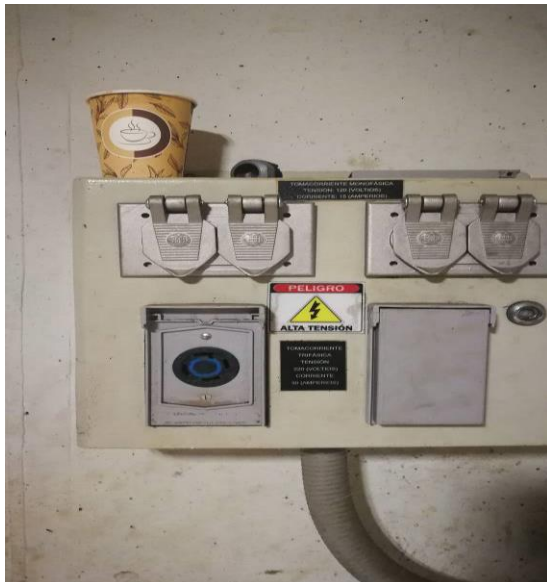
Foto 20. Tomacorriente trifásico sin protector Unidad 5
