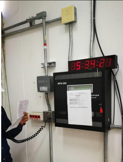
Foto 22. Tablero de Sistema de Perifoneo en prueba
