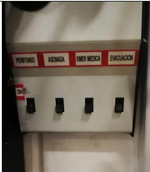
Foto 10. Interruptores de tono del sistema de perifoneo
