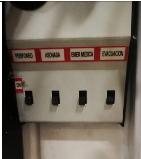
Foto 5. Interruptores de tono del sistema de perifoneo
